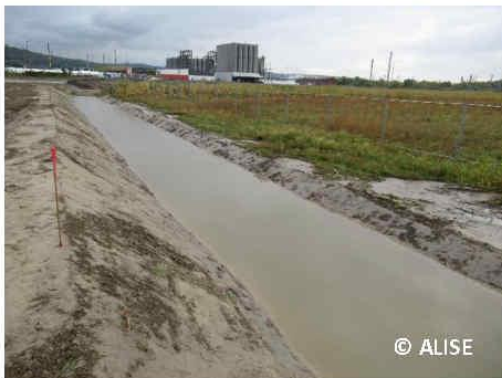
Photo 3 : Pentes douces du nouveau fossé côté culture
