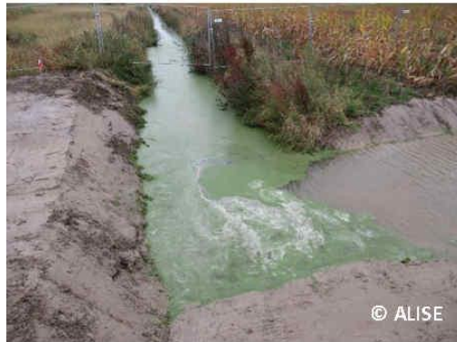
Photo 5 : Liaison entre le nouveau et l'ancien fossé
