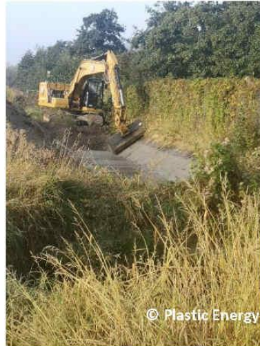
Photo 2 : Création du nouveau fossé avant comblement de l'existant (au premier plan)
